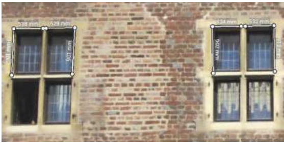
Aus zwei Stereoaufnahmen von seitlich versetzten Standpunkten errechnet die Software die Maße
